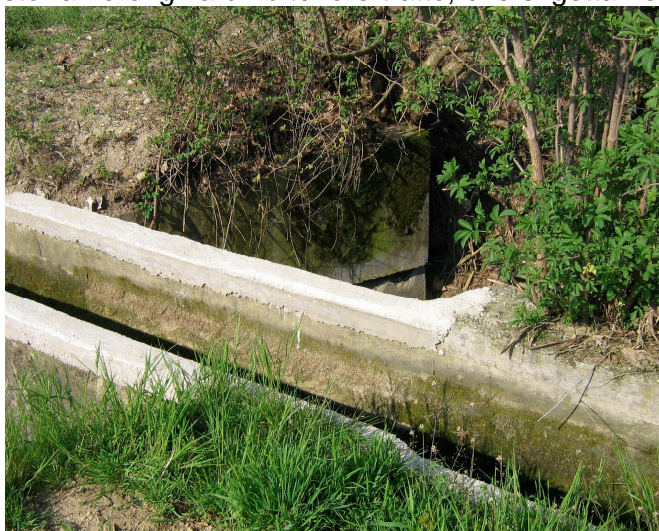
Sovrapasso della Bonforta sul Vaso Fiume, presso il Cimitero
